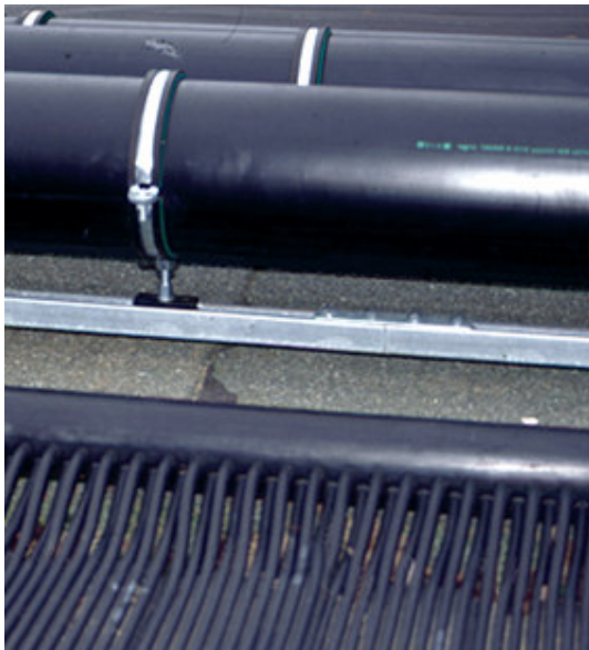
14. ábra: Példa elcsúszásra képesen telepített csövekre
