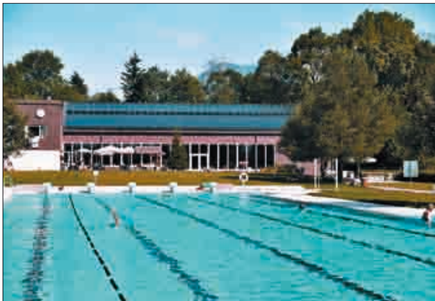
Bild 1: Freibad mit Absorberanlage
