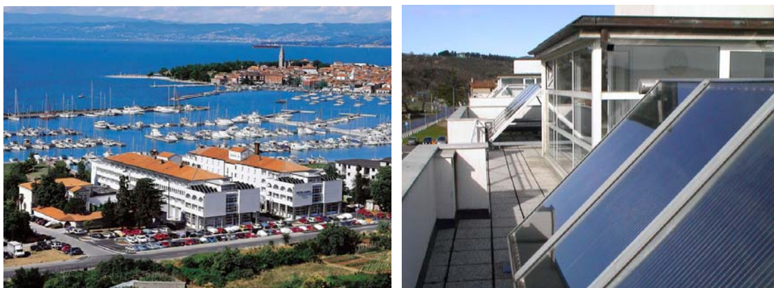
Slika 1: Ploščati SSE na Hotelu Delfin
