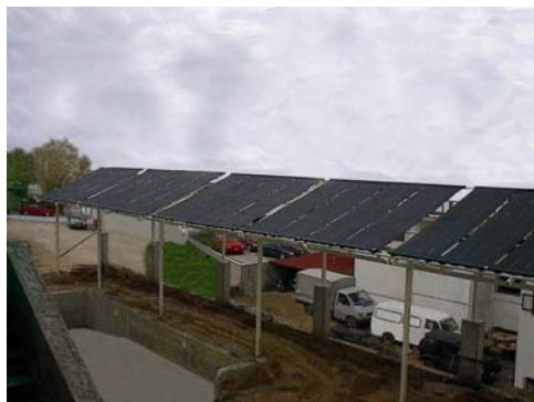
Εικόνα 7 Εγκατάσταση ΘΗΣ για θέρμανση κολυμβητικής δεξαμενής στο Ρέθυμνο Κρήτης
